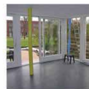
aanbouw, schuifpuien, kozijnen.
